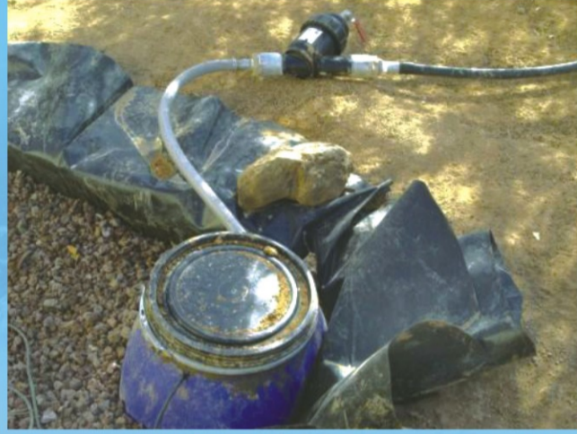
برميل التجميع النهائي في حوض المعالجة والمزود بمضخة غاطسة وعوامة اتوماتيكية
