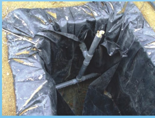
كيفية دخول المياه الى حوض المعالجة وتوزيعها
